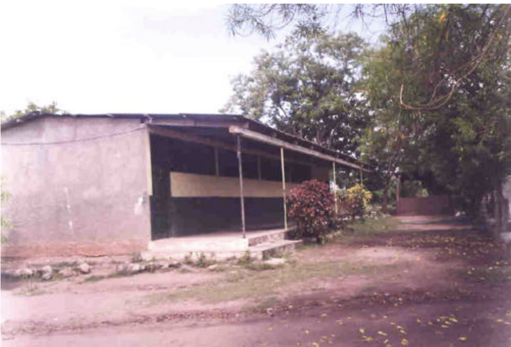
Escuela con techo reparado con fondos del PNRIV en Agalteca (Tolupanes)
